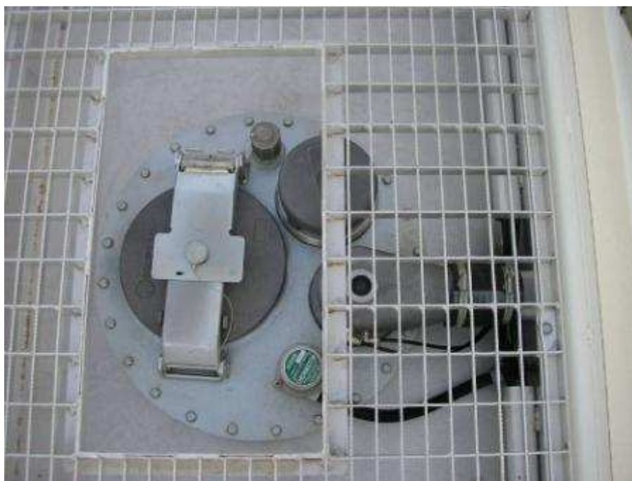
FOTO: boca de hombre de una cisterna de gasolina para lavado, inspección y reparación. (Suelen cargarse por la parte inferior para evitar el riesgo laboral de caída de altura del trabajador).
